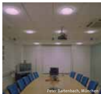
Vor dem Umbau: Blendung durch Dominanz der Leuchten führte zu erschwelter Wahrnehmung.
